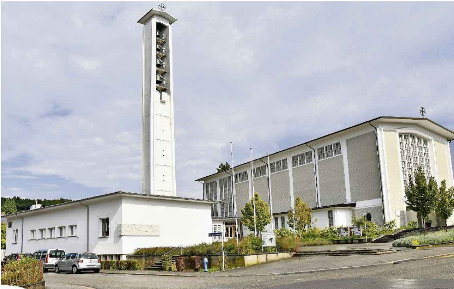
Kirchliche Gebäude bergen ein hohes Potenzial an Energieeffizienz; hier die Oltner Marienkirche.
